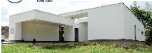
PROMO Yard House - niske energetska montažna kuća sagrađena 2009.g. u Kristianstadu, Švedska, godišnje troši samo 53 kWh/m² za zagrijavanje, odnosno hlađenje.
